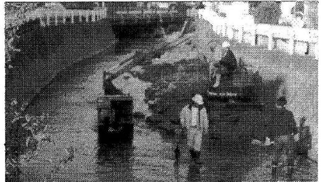
▲洪水災害を受けての堺川復旧工事
