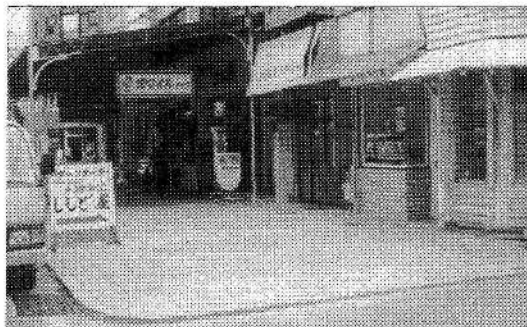
▲中通2丁目の歩道を修復舗装
