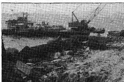
▲天応大浜の護岸復旧工事
