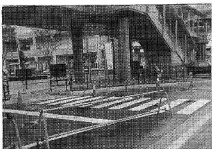
▲中央棧橋から直通路設置
