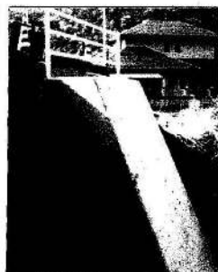
▲法面に要壁築造
