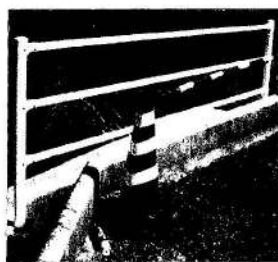
▲転落防止用手摺り
