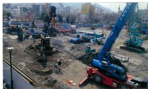
▲新庁舎建設が着々進捗する工事現場
