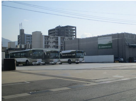
▲広電が取得・新築中の中央工場
