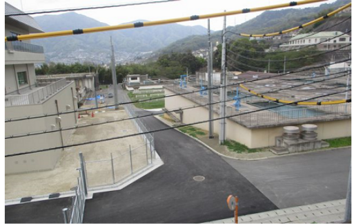
▲大規模な断水に陥った宮原浄水場
