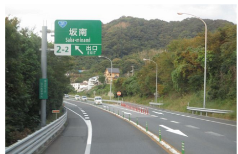
▲令和2年無料化予定の広島呉道路
