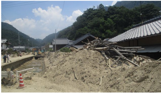
▲土石流で土砂が堆積した天応西条
