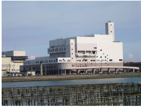
▲焼却炉を備えるクリーンセンター
