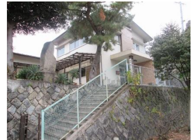
▲築54年が経過した二川児童館
